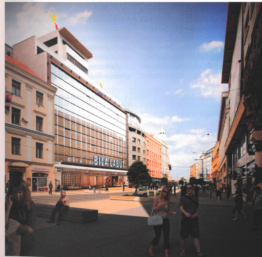
Současný majitel obchodního domu Oldřich Petráček a jeho společnost Transakta chce rozsáhlou rekonstrukci stavbu v centru Prahy vrátit na výsluní. Spolupracuje přitom s architektonickým ateliérem TaK.
