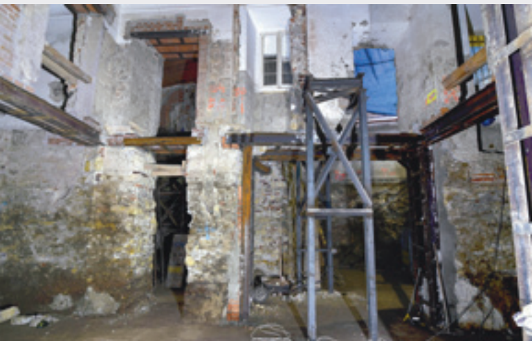
▼ Nově vznikající suterén s komplikovanými stavebními úpravami
