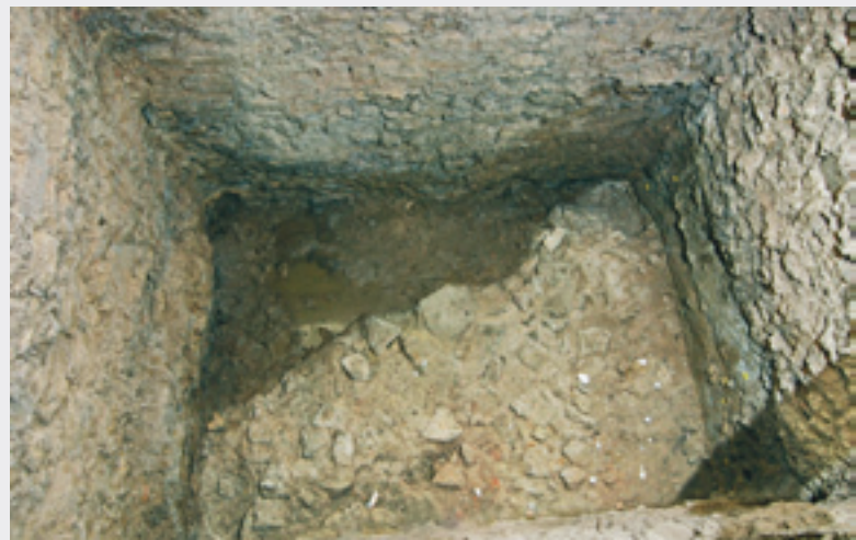
▼ Část odhalených základů pilíře Juditina mostu
