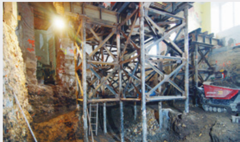
▲ Mikropilotové bárky v místě nově naváženého pilíře
