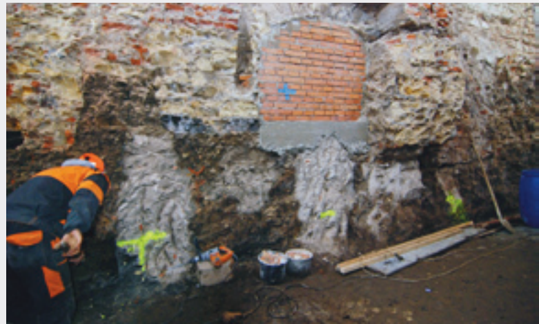
▲ Základové konstrukce v suterénu posílené dobře viditelnými sloupy tryskové injektáže
