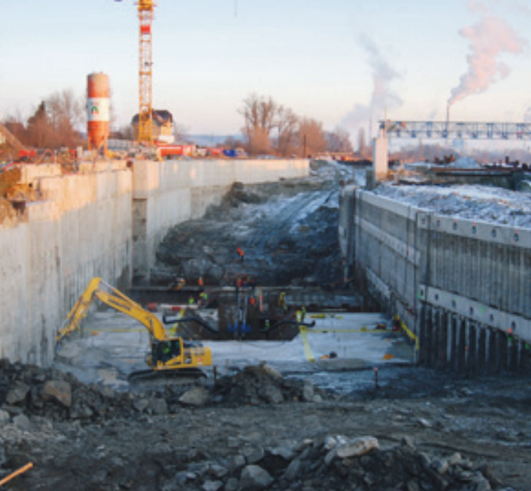
▲ Betonáž základové desky strojovny MVE v nejhlubším místě stavební jámy
