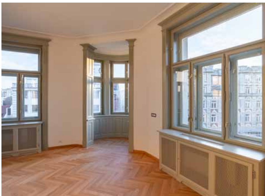
Vnější okna byla vyrobena jako repliky, vnitřní restaurována
