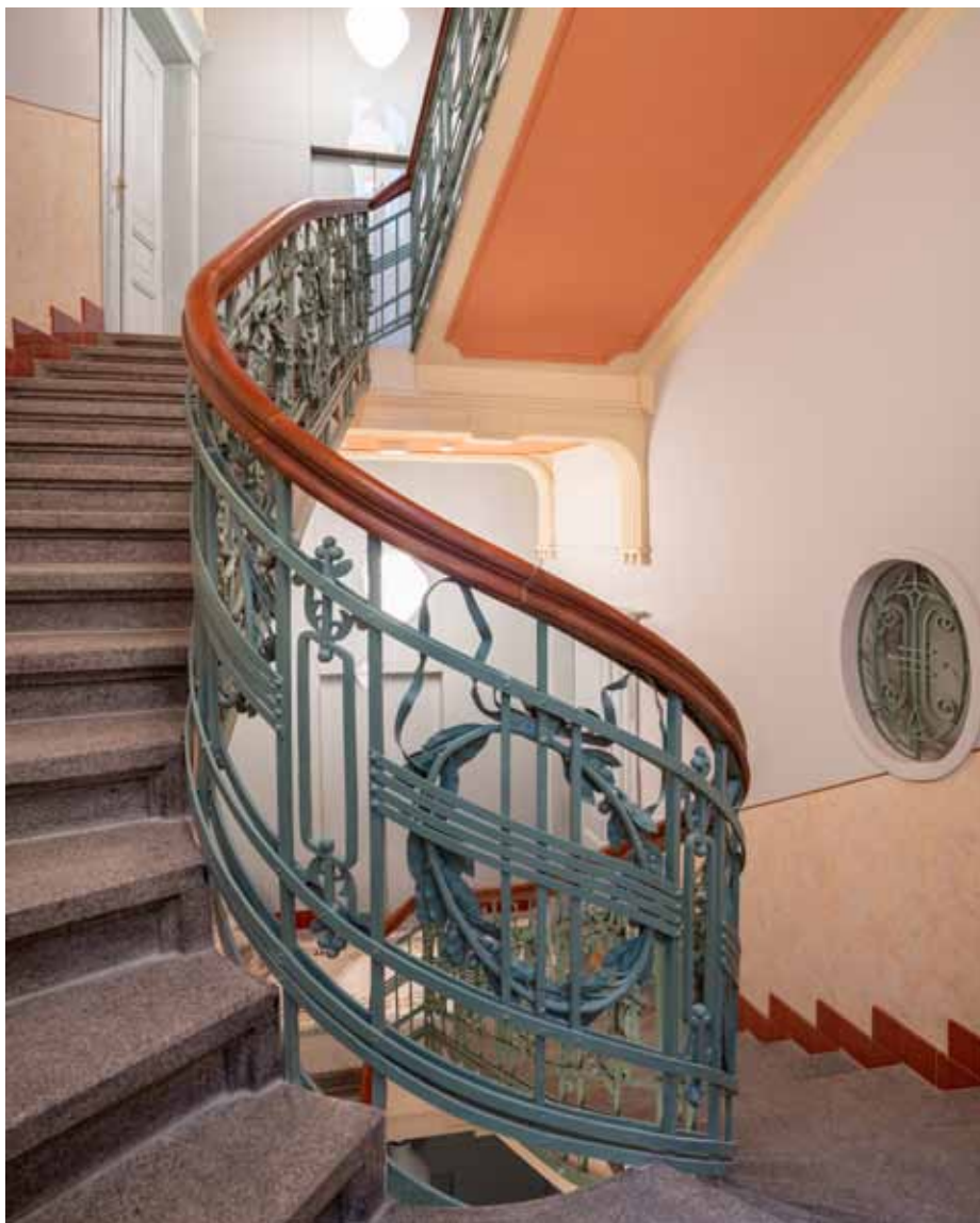
Bohatě vzorované zábradlí u schodiště
