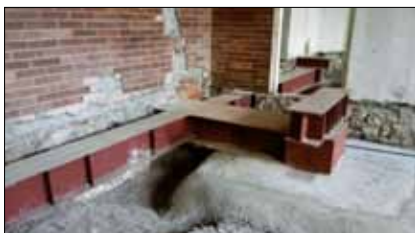
Ocelový rošt ve 2. NP
