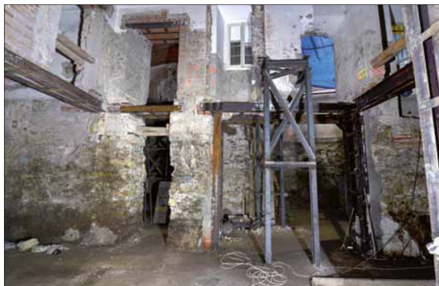
Nově vznikající suterén s komplikovanými stavebními úpravami
