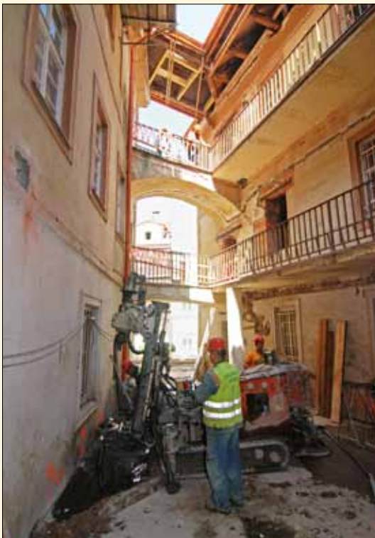
Podchycování základových konstrukcí tryskovou injektáží z dvorku Pinkasova paláce
