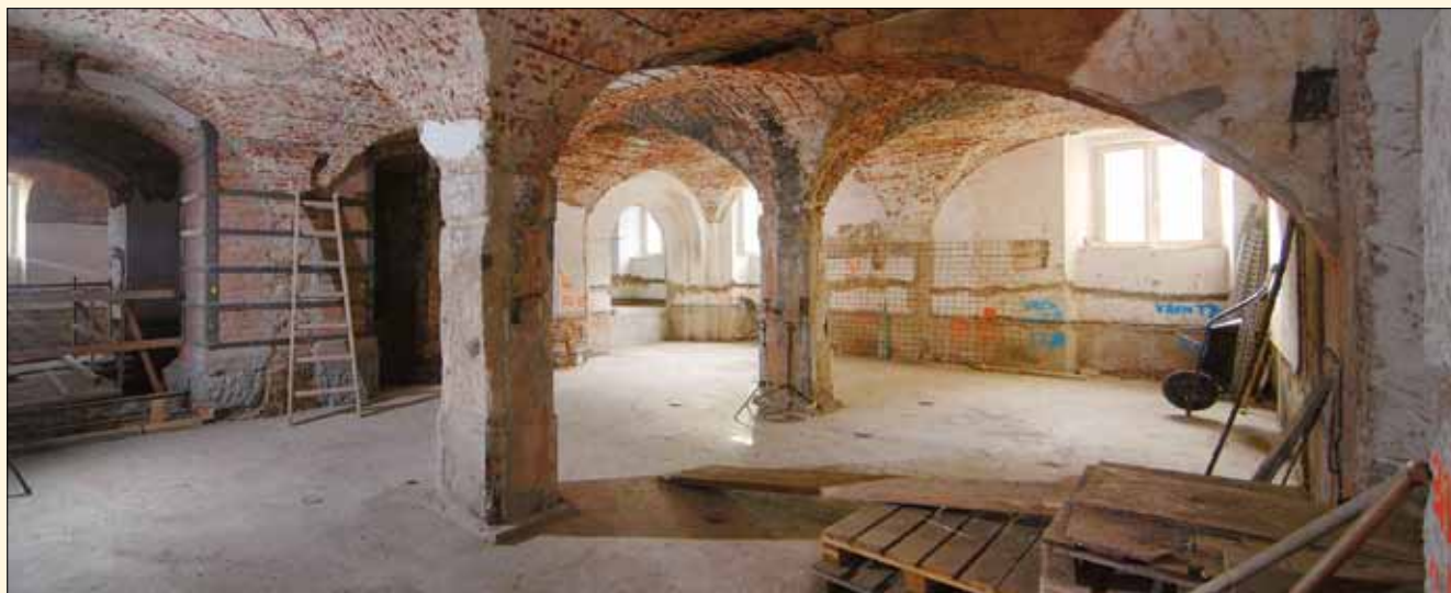
Očištěná barokní místnost s nově založenými a posílenými sloupy SL1 a SL2
