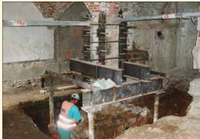
Sloup SL2 podchyčený pomocí MP bárek
