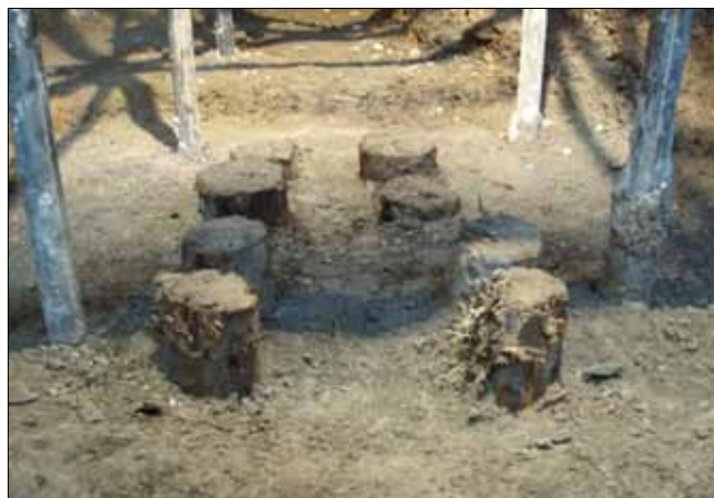
Původní dřevěné piloty v místě plánovaného pilíře č. 1
