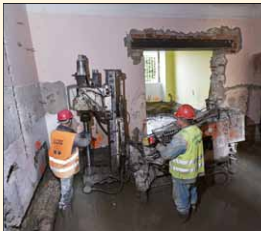
Provádění tryskové injektáže probíhalo často z velice stísněných prostor
