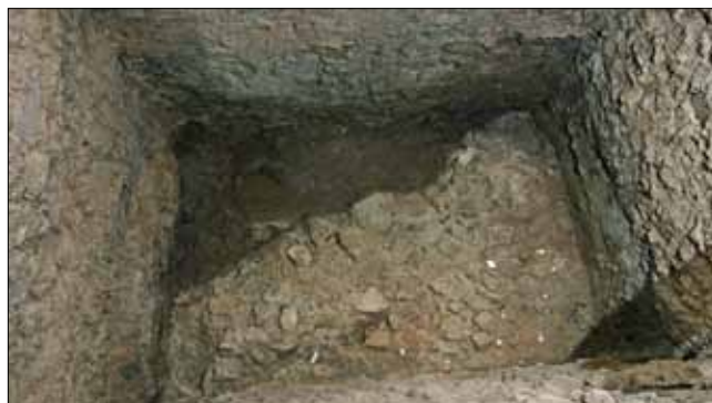
Část odhalených základů pilíře Juditina mostu
