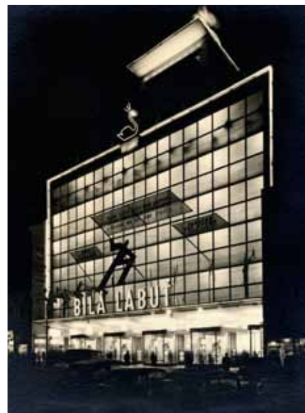
Důležitou součástí efektu fasády bylo i její noční osvětlení. Architekt Kittrich: „Zasklené uliční průčelí 33/18 m prosvětlováno jest 100 kusy výbojek Philora SO 400. U výkladních skříní jest použito smíšeného světla rtuťových výbojek Philora HP 300 a běžných žárovek (dosaženo bělosti denního světla). Vysunutá deska dominanty jest podsvětlována sodíkovými lampami. Večerní osvětlení jest zdůrazněno neonovým osvětlením v rozsahu 1000 m trubíc a asi 100 transformátorů.“
