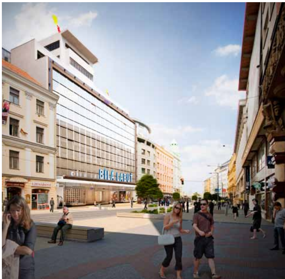
Současný majitel obchodního domu Oldřich Petráček a jeho společnost Transakta chce rozsáhlou rekonstrukcí stavbu v centru Prahy vrátit na výsluní. Spolupracuje přitom s architektonickým ateliérem TaK.
