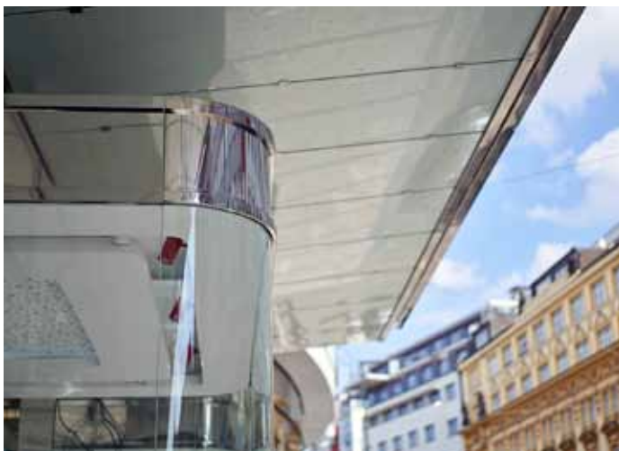
Markýza nad vstupní částí má rozměry 32 x 6 m
