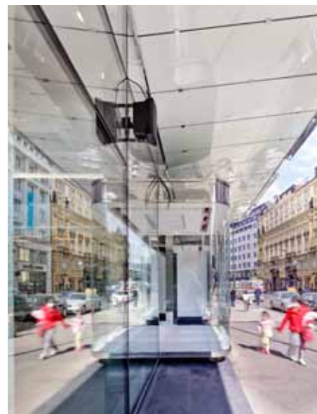
Výkladce byly řešeny podle původního návrhu, opět mají zaoblená skla
