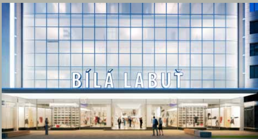
Nápis Bílá labuť a jeho nosná konstrukce jsou nové. Nové je také osvětlení, které je převážně kopií původního.
