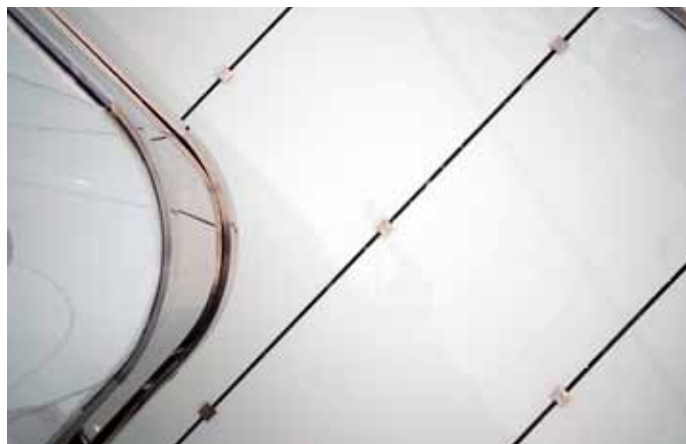
Povrch markýzy tvořila vysoce leštěná sádrová kletovaná stěrka. Tuto technologii bez dilatací autoři nedokázali obnovit, proto se rozhodli pro sklo. Výsledný efekt je velice podobný.
