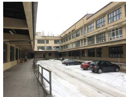
Budova E před rekonstrukcí ...
