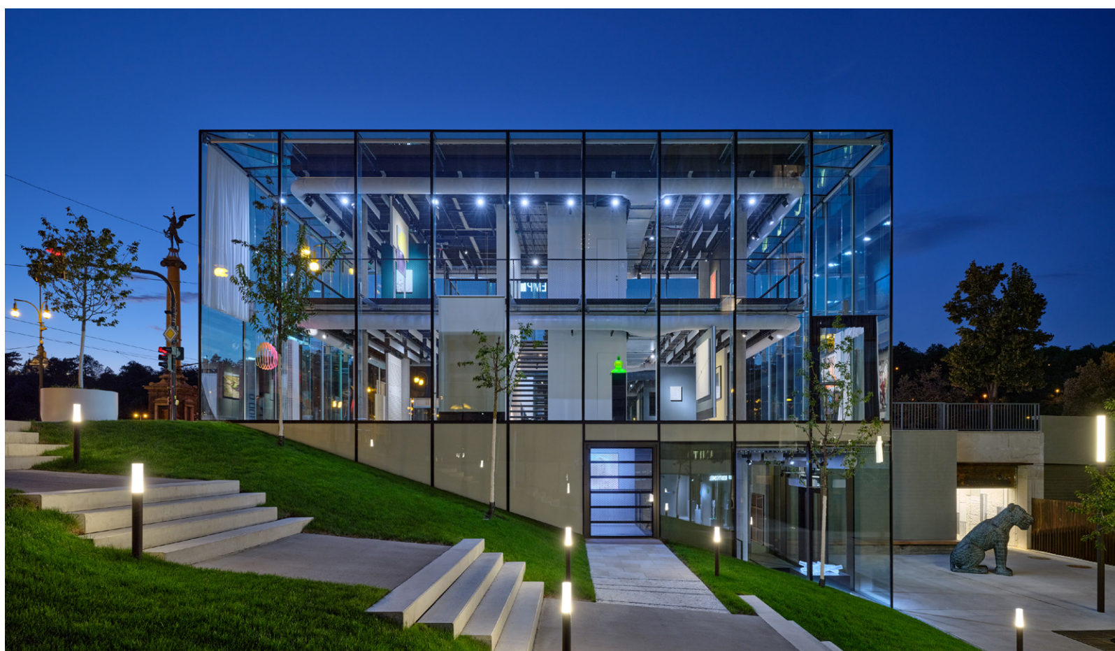
Kodl Contemporary – galerie moderního umění, Praha 1 - Dvořákovo nábřeží / Pařížská ulice (2026)
